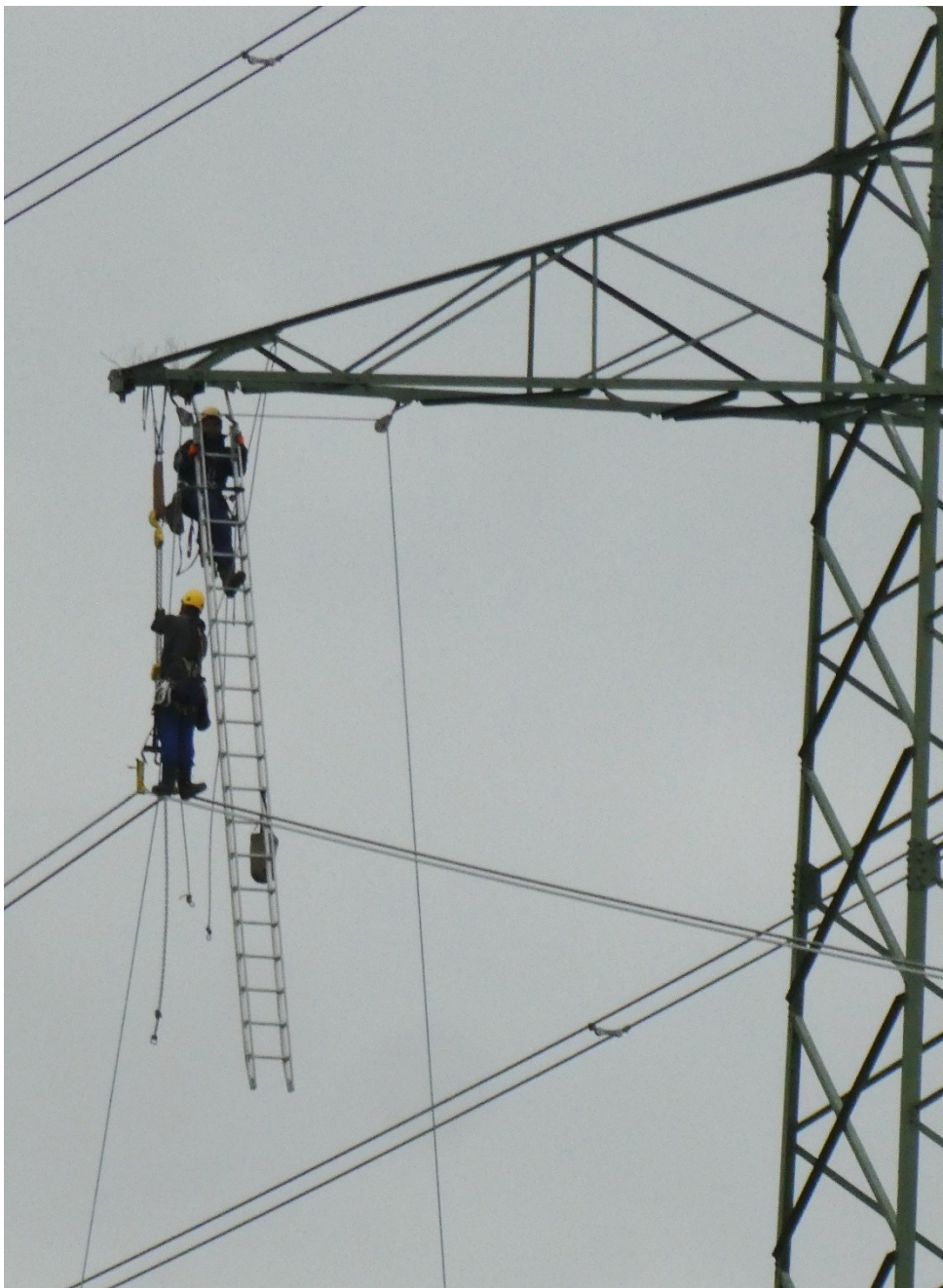
Arbeit am Strommasten
